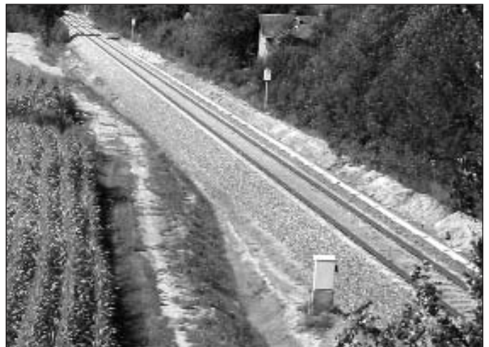
Die modernisierte Hauptbahn Leipzig - Chemnitz Blick vom Aufsatzboden zur Waldfestwiese, Foto - Rainer Goldammer
